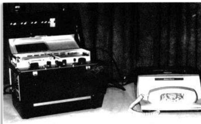
Рисунок 4.1.1.100. Комплект передающего оборудования: электрокардиограф Viso 100 Sanborn и X603AM / X603BM dataphone
