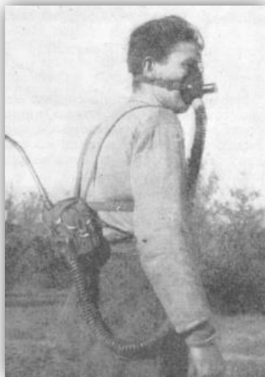
Рисунок 4.4.3.1. Радиобиотелеметрическая система для исследований функций дыхания, Болгария, 1953-1955 гг. [5]
