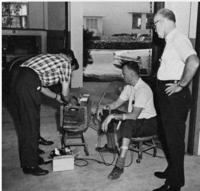
Рисунок 4.1.1.69. Первое испытание радиотелеметрической системы Nagel-Hirschman для догоспитального этапа (США, около 1967 г.), ранняя модификация прибора в ящичке из-под молочных бутылок проходит испытания в гараже проф. Nagel [152-154]
