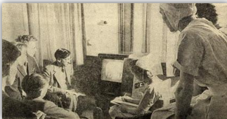
Приемники в аудиториях и других помещениях больницы
